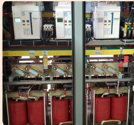
快速旁路双向可控硅及补偿变压器
