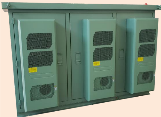
全密封不锈钢保温箱体及防腐空调系统
