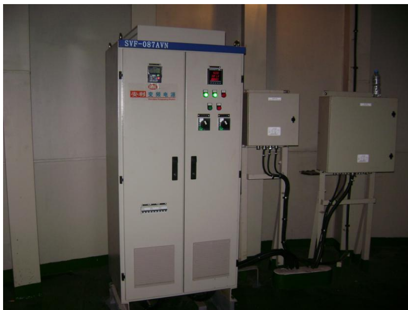
SVF 系列游艇（拖轮）专用岸电电源设备
